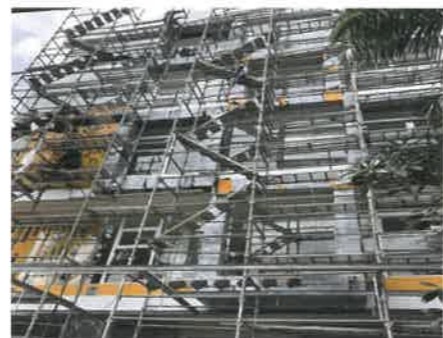
幼稚園建設現場 (ホーチミン市)
