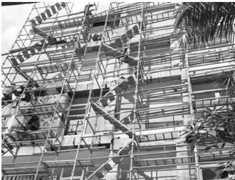
写真-6 幼稚園施工現場（ホーチミン市）
